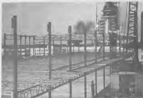
THE SECOND floor begins to take shape as a steel skeleton. E SEGUNDA piso ta cuminsa haya forma como un skeleton di staal.
